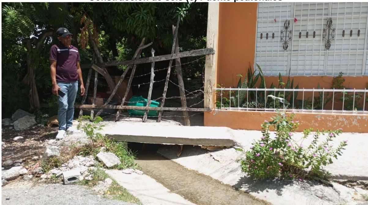
Puente Peatonal en la calle circunvalación
