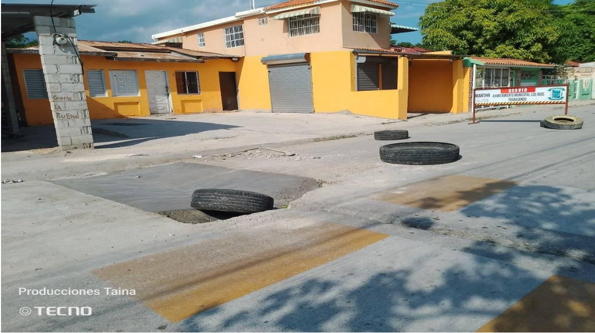
Reparacion de baden en la Avenida Las Viñas, Frente a la gomera
