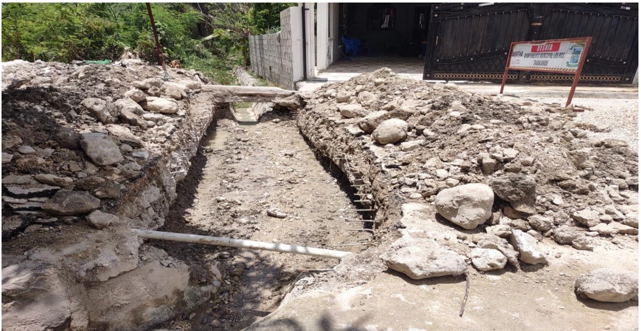
Reconstrucción de Puente Peatonal calle Antonia Sosa, sobre el canal No 1
