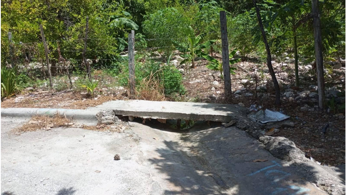
Construcción puente peatonal frente de la casa de Kelin
