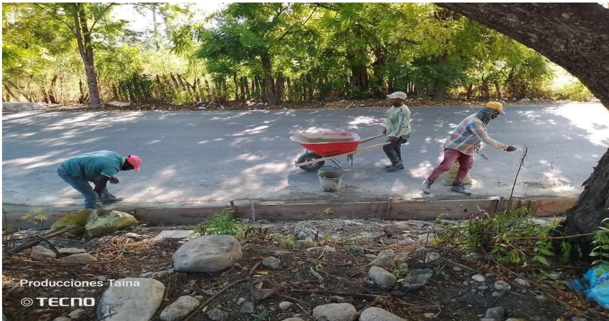
Fotografía Construcción de Aceras y Contenes Sector Hato Nuevo, Entrada del Municipio.
