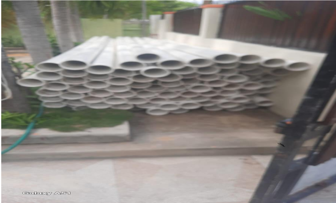
Obra Mejoramiento Suministro de agua potable Sector La Javilla. El Cachimbo PPM 2025
