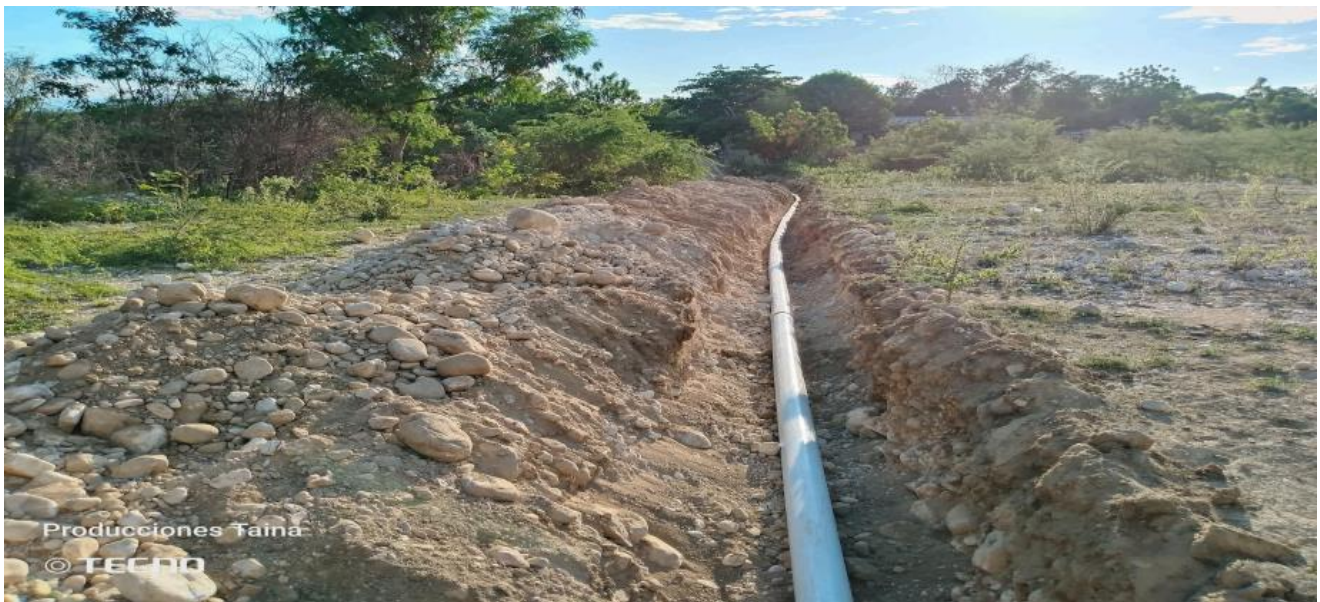
Obra Mejoramiento Suministro de agua Potable Sector Lengua Azul PPM 2025
