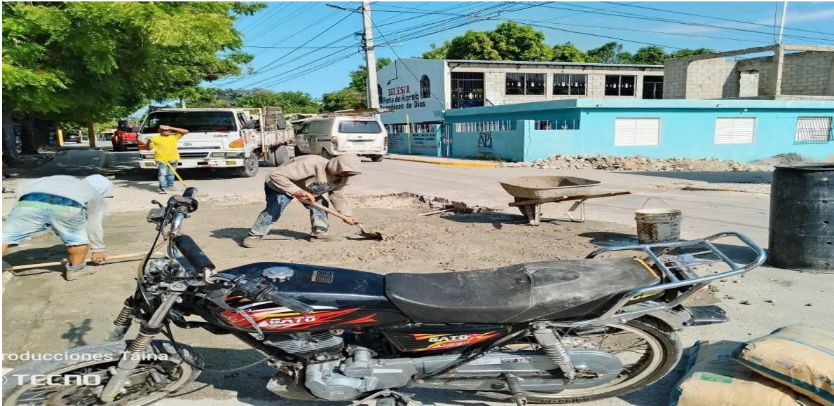
Mano de obra reparación canalito parque central y Primera Reconstrucción badén en la Picantina .
