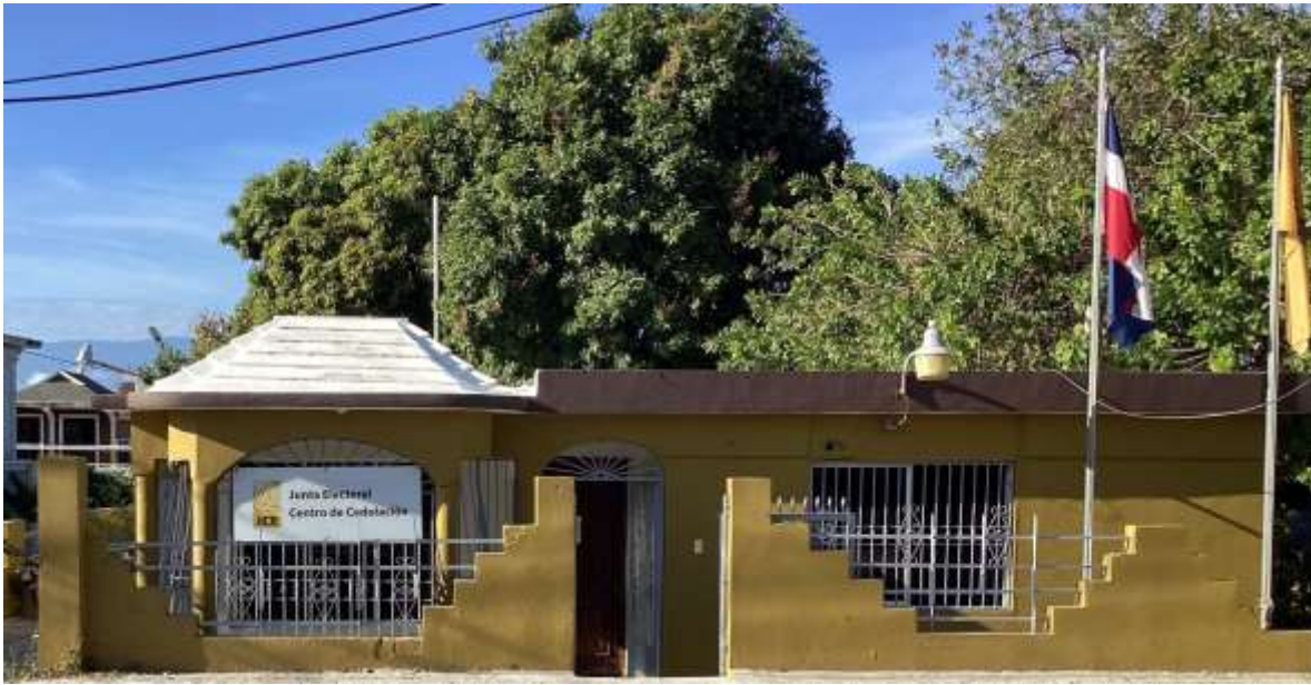
Oficinas Junta Municipal Electoral y Oficialía Civil.
